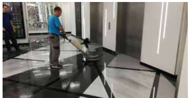
impregnace protismyku
